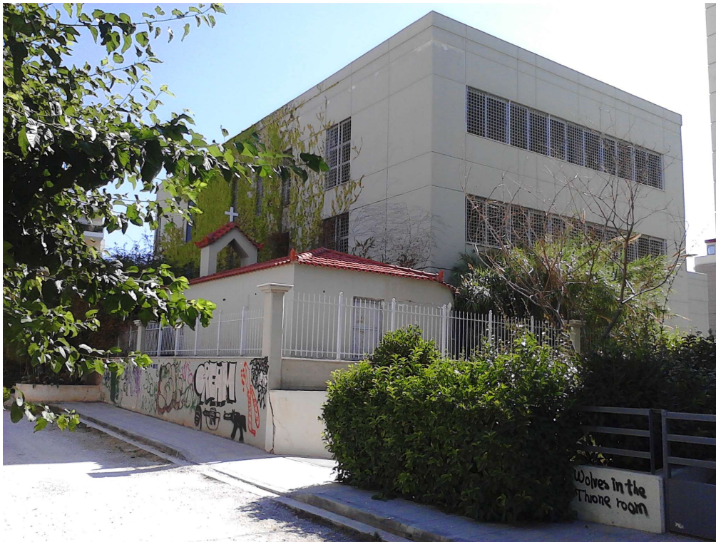
Φωτογραφία της ΒΔ πλάγιας όψης (επί του βορειο-δυτικού πεζόδρομου) και τμήματος της ΝΔ οπίσθιας όψης, από την δυτική γωνία του οικοπέδου..
