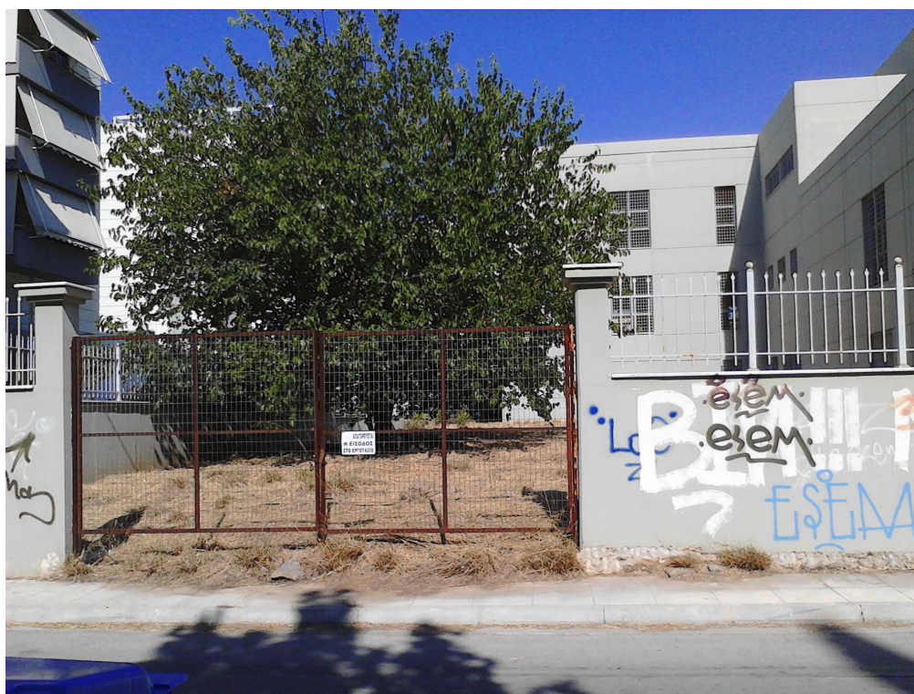
Πλάγια Όψη από τον πεζόδρομο της οδού Τυμφρηστού
